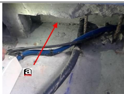
Photo n° PhA002 Localisation : Rez de chaussée - Local technique 4 Ouvrage : 4 - Plafonds et faux plafonds - Plafonds Partie d'ouvrage : Panneaux collés vissés ou cloués Description : Panneaux collés vissés ou cloués
