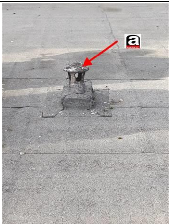
Photo n° PhA004 Localisation : 5ème étage - Toit terrasse Ouvrage : 1 - Couvertures, Toitures, Terrasses et étanchéités - Éléments associés à la toiture Partie d'ouvrage : Conduit de ventilation + Mitron Description : Conduit de ventilation + Mitron
